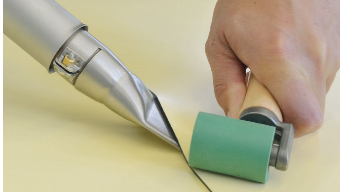
Zgrzewanie na zakładkę folii hydroizolacyjnej
