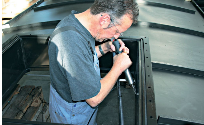
Spawanie przy pomocy Leister DIODE PID
