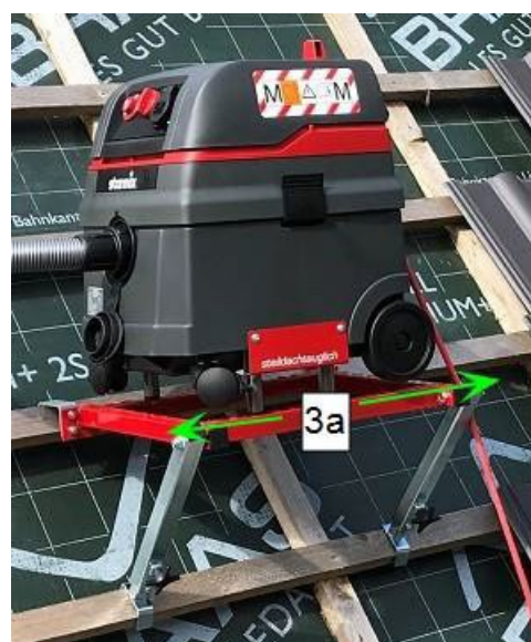
Przykręcanie płyty mocującej
