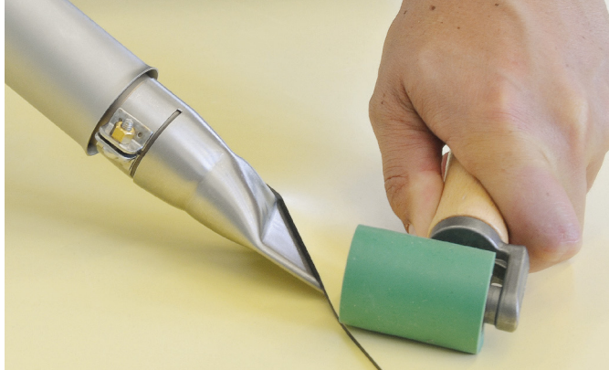
Zgrzewanie powłoki na biogazownię
