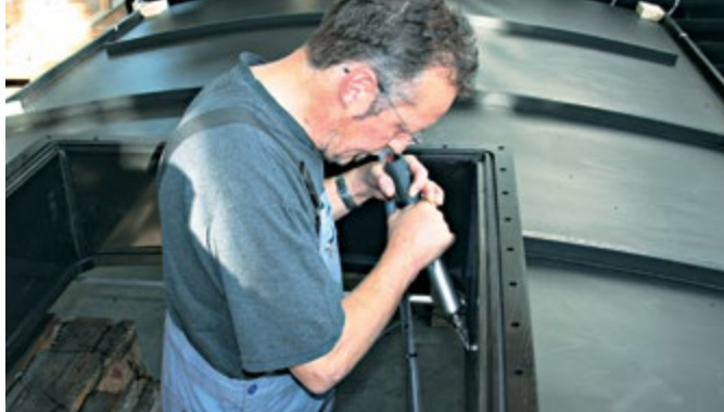
Spawanie zbiornika z PE przy pomocy DIODE PID.
