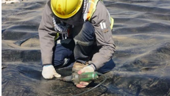
Zgrzewanie geomembrany
