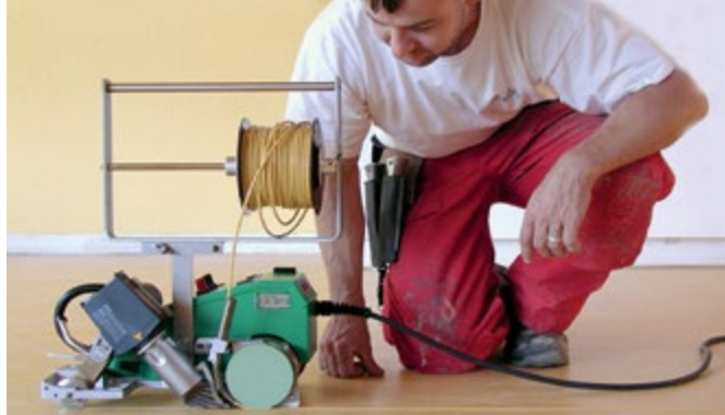
UNIFLOOR E z rozwijakiem podczas spawania linoleum.
