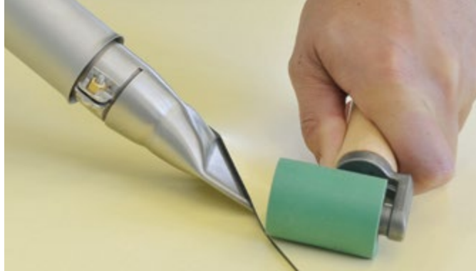
Zgrzewanie na zakładkę folii dachowej
