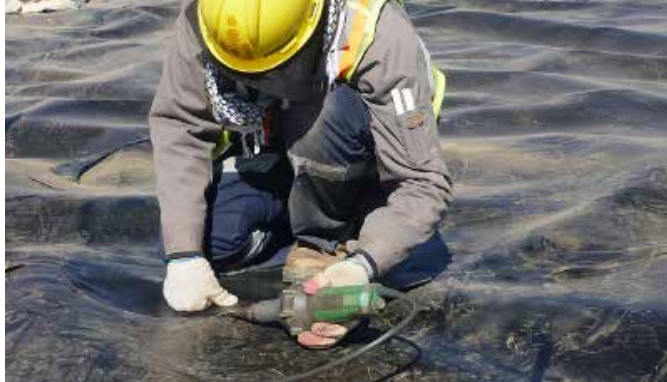
Zgrzewanie geomembrany
