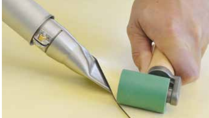
Zgrzewanie na zakładkę folii dachowej
