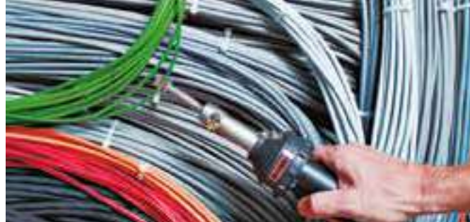
Obkurczanie otuliny za pomocą HOT JET S z reflektorem sitkowym
