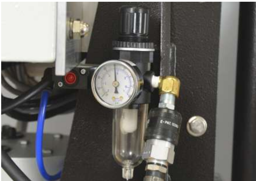
Abb. 10 Druckluftregler-Trennanschluss
